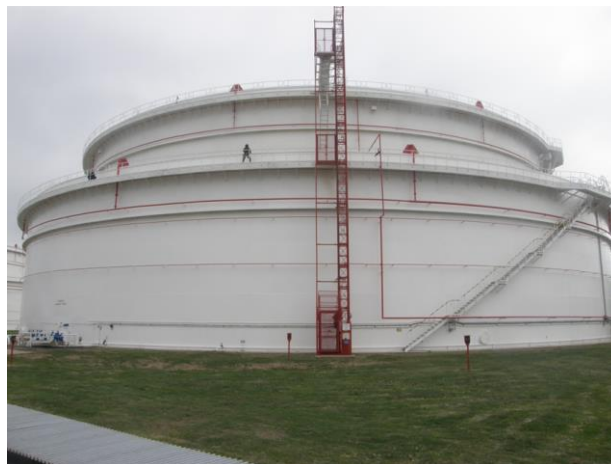
Obrázok 4 Skladovacia nádrž s objemom 70 000 m 3 [2]
